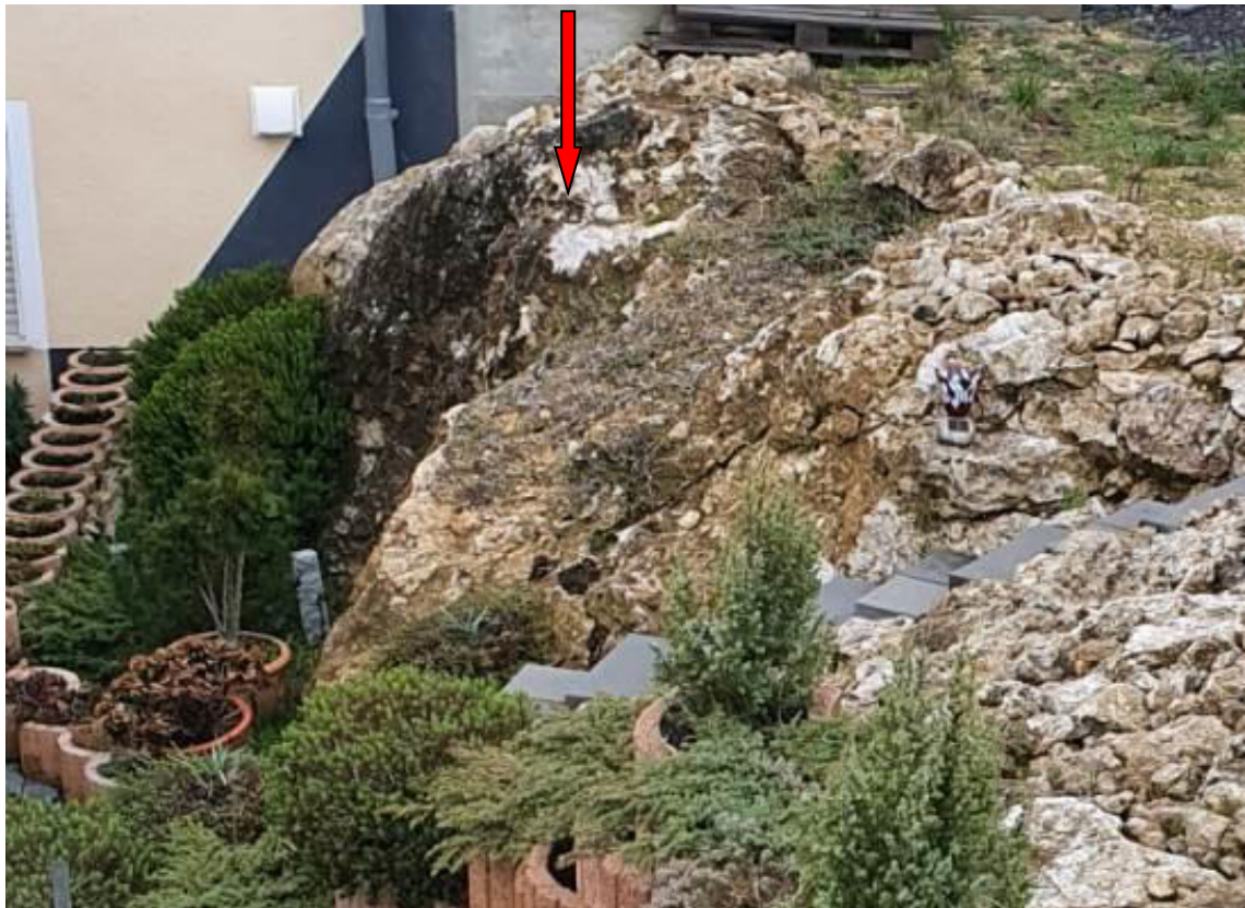
Foto 6 - Nachbargrundstück - Kalkstein im Bereich des hangseitigen Untergeschosses
