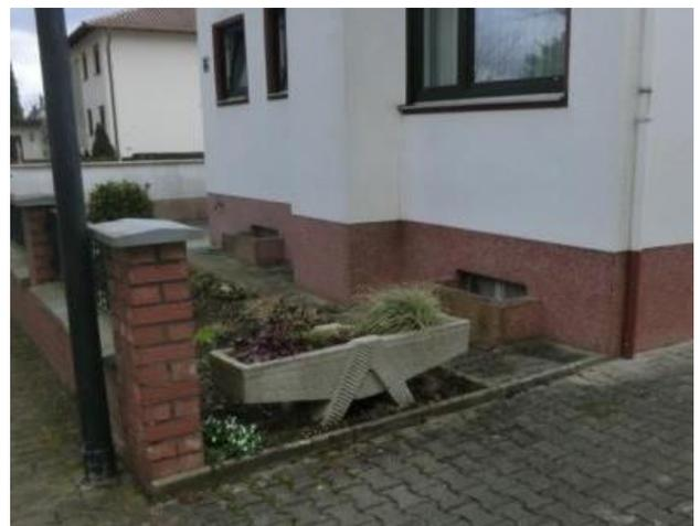
An der Hauptstraße, wo die Lichtschächte im Gehweg liegen, kommt eine solche Lösung allerdings nicht infrage. Sofern möglich, können die Fensteröffnungen dauerhaft verschlossen, also beispielsweise zugemauert werden.
