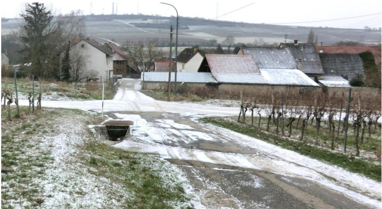
Weder das Einlaufbauwerk noch die Verrohrung können eine Sturzflut aufnehmen und bei Starkregen schießt Wasser über das Bauwerk hinweg in die Ortslage.
