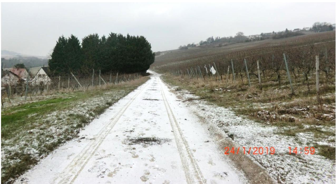
An der Wegkreuzung zum Schlittweg fehlen leistungsfähige Gräben, Furten oder Durchlässe. Schon bei kleineren Regen kommt es hier zwangsläufig zur Überflutung.
