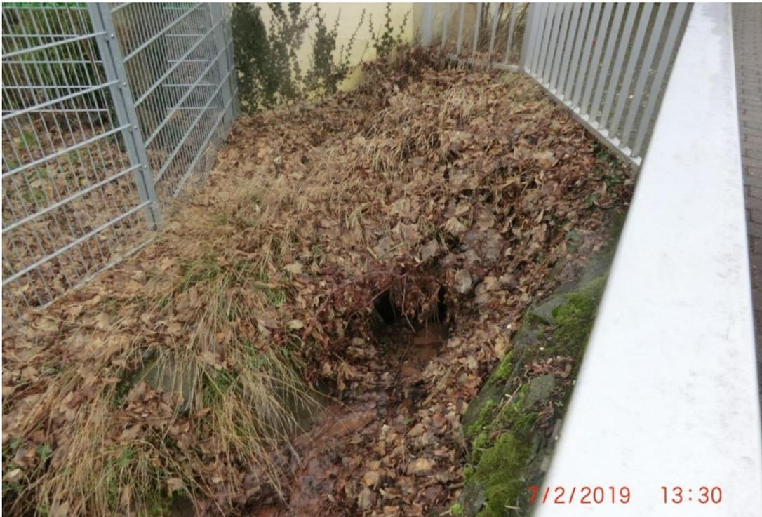
Bei Starkregen ist der heutige Rosengartenbach hydraulisch überlastet und es kommt zu einem breitflächigen Oberflächenabfluss in der alten Bachtrasse (rotes Oval). Die Situation entspannt sich künftig etwas, wenn durch die, in Abschnitt 3.1 beschriebenen Maßnahmen, der Außengebietszufluss insgesamt reduziert wird.
