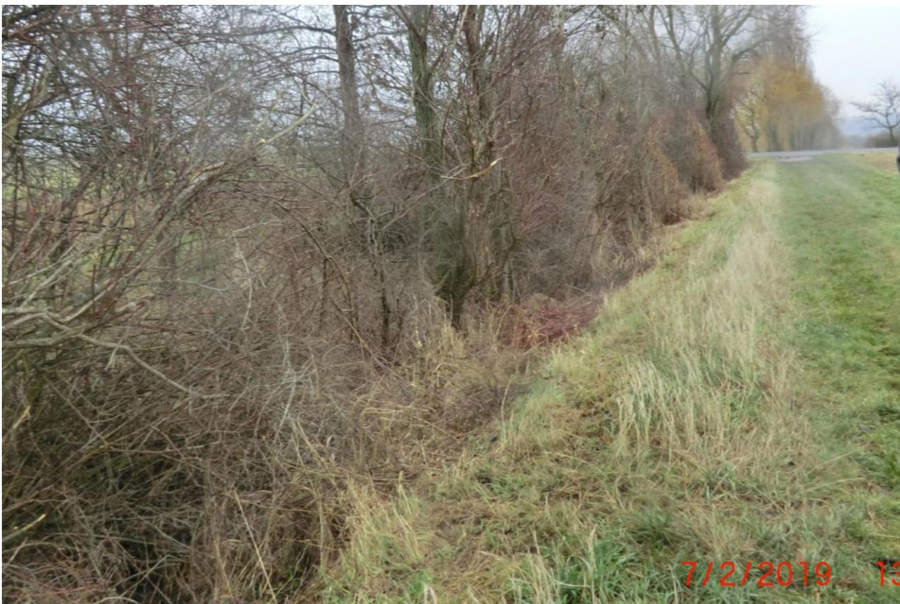
Zudem besteht am Problempunkten 2 die Gefahr, dass das zufließende Außengebietswasser aus dem Graben austritt und dann dem Wohngebiet Sommerwiese zufließt. Insbesondere hier sollte der Graben breiter und tiefer hergestellt werden. Eine zusätzliche talseitige Verwallung erhöht die Sicherheit.
