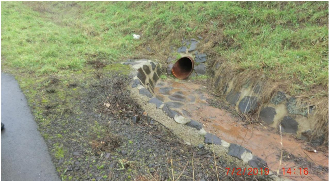
An beiden Auslässen kam es in der Vergangenheit zu Erosionen und Abspülungen am Weg, so dass dieser erneuert werden musste. Nach Umsetzung von Sicherungsmaßnahmen sind keine Schäden mehr aufgetreten. Allerdings war zum Zeitpunkt der Ortsbegehung Schlamm auf dem Weg sichtbar. Es wird empfohlen die Entwässerungseinrichtungen regelmäßig zu kontrollieren und zu säubern.
