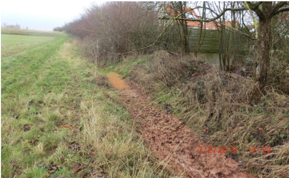
Nach einem Starkregenereignis mit Schäden an der Wohnbebauung wurden zusätzlich entlang des Rosengartenbachs Anschüttungen hergestellt, um zufließendes Außengebietswasser sicherer an der Bebauung vorbei leiten zu können. Der Graben war zum Zeitpunkt der Ortsbegehung aufgelandet ...
