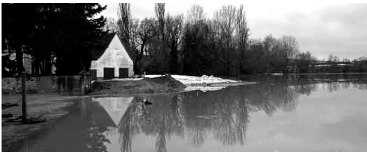
Januar 2011: Hochwasser aus Pfrimm und Leiselsbach im Retentionsgebiet Kleinmühle
