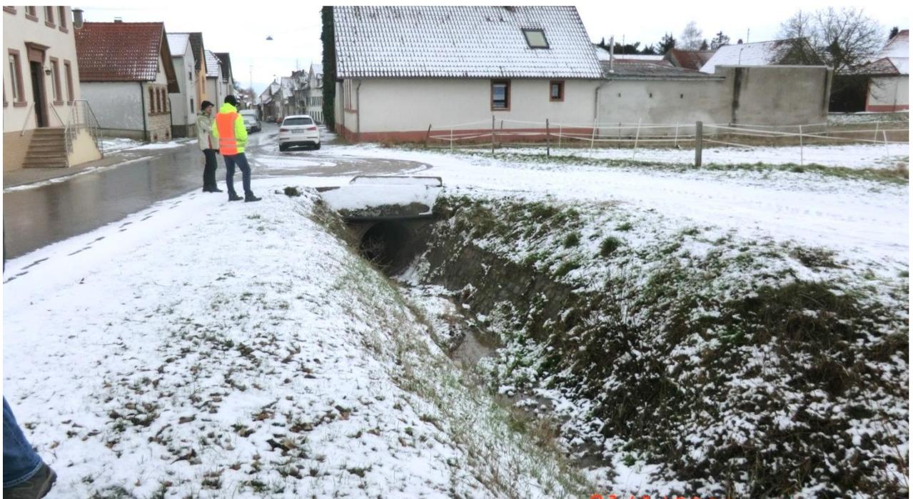
Bei dem Starkregen 2008 war das Bachbett unmittelbar oberhalb der Verrohrung zwar vollgefüllt, der Einlauf in die Verrohrung erzeugte jedoch noch keinen Aufstau, was für die Leistungsfähigkeit der Verrohrung spricht.
